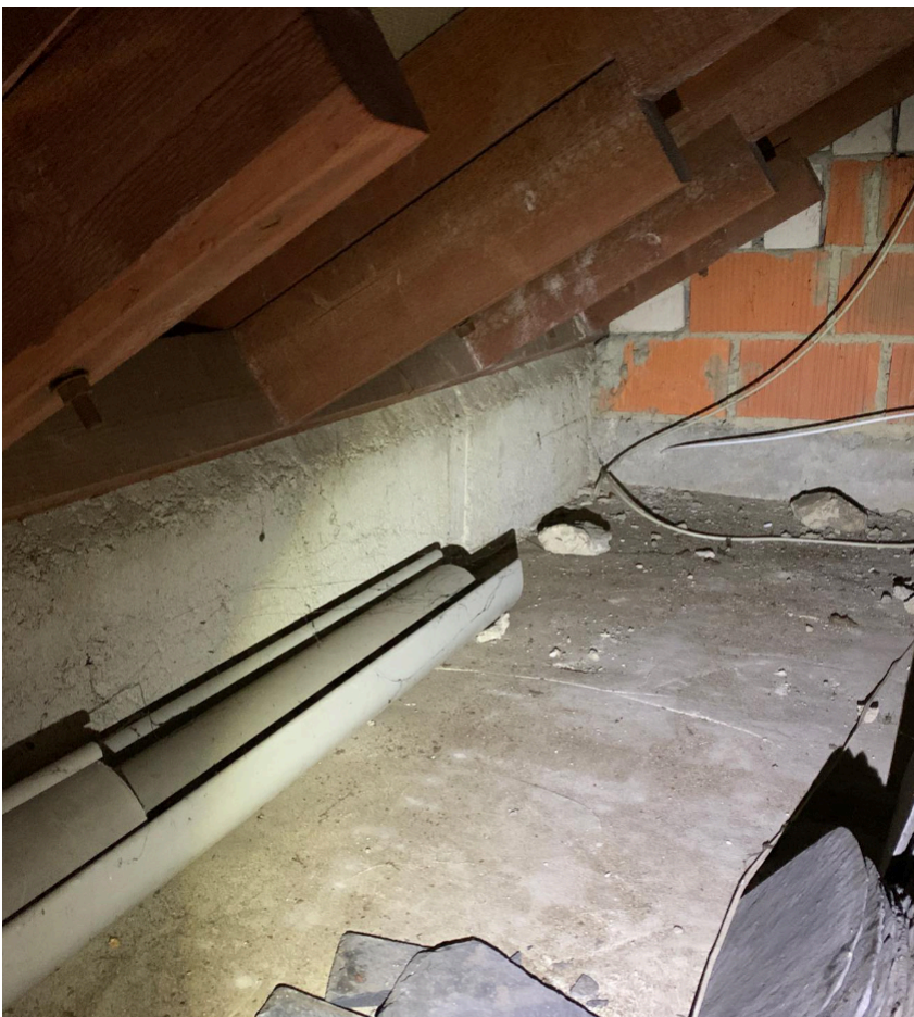
Abb. 93: 1990 Abseitenraum Schimmel unter ungedämmter Stahlbetondecke
