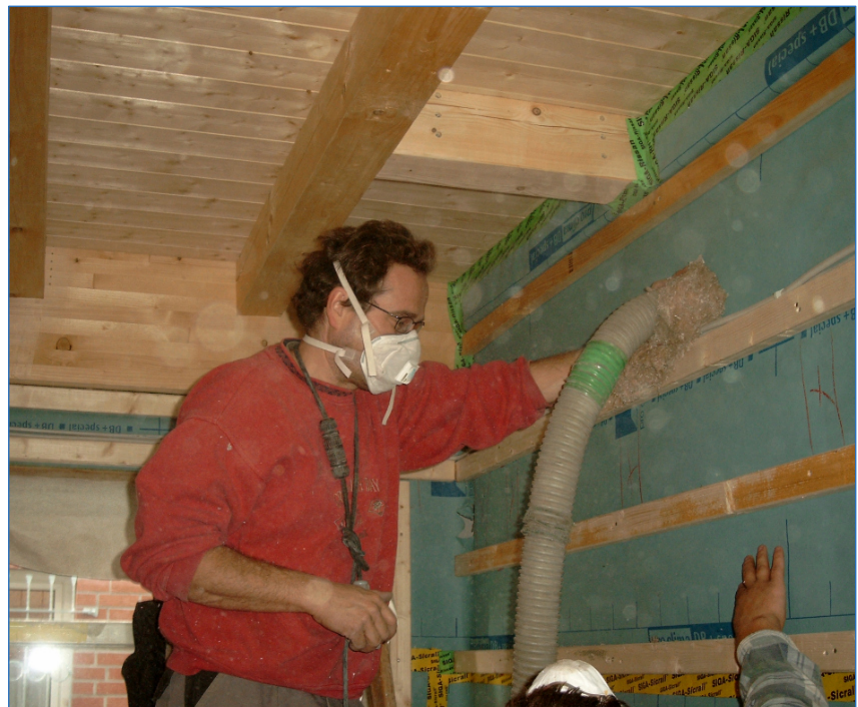
Abb 35: Einblasdämmung ist im Holzständer- oder Rahmenbau eine übliche Technik
