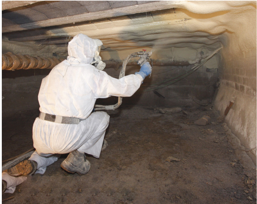
Abb 60: In Holland und England übliche PU-Sprühdämmung ist in feuchten Milieu geeignet
