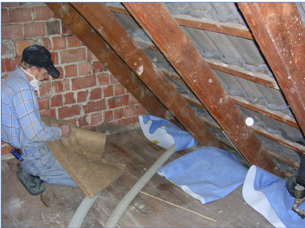
Abb 75 - 78: Thermo-Bag zwischen den Sparren wird mit Zellulosedämmstoff gefüllt. Der Bag wird mit dem überschüssigen Material gestopft und verklebt. Nun kann auf der Kehlbalkenlage mit dem Einblasdämmverfahren fortgefahren werden.
