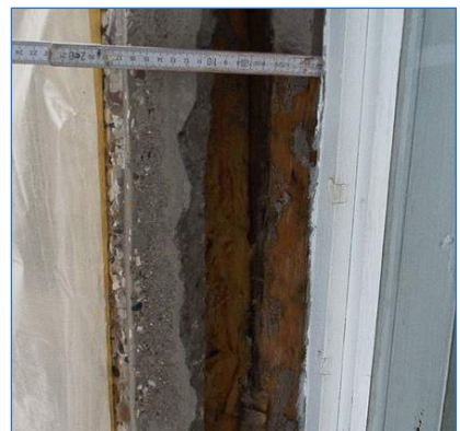
Abb 43: Blick in den funktionslosen Luftzwischenraum
