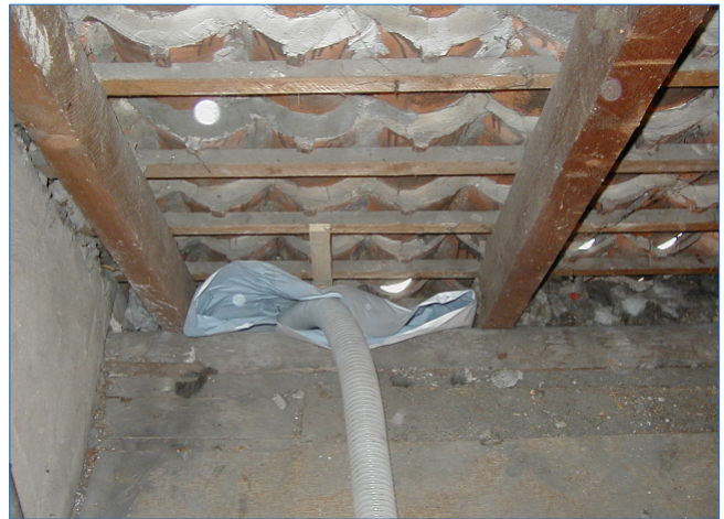
Abb 75 - 78: Thermo-Bag zwischen den Sparren wird mit Zellulosedämmstoff gefüllt. Der Bag wird mit dem überschüssigen Material gestopft und verklebt. Nun kann auf der Kehlbalkenlage mit dem Einblasdämmverfahren fortgefahren werden.
