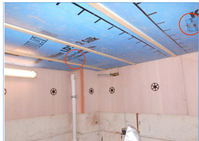
Abb. 54: Rohre verschwinden unter der Abhängung (rote Kreise = abgeklebte Einblasöffnungen für den Dämmstoff)
