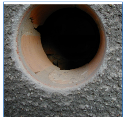
Abb 43: Blick in den funktionslosen Luftzwischenraum
