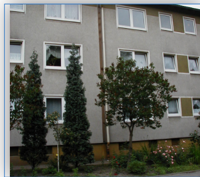
Abb. 146: Trennfuge zwischen MFH Baujahr 1968
