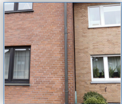
Abb. 148: Offene Trennwandfuge
