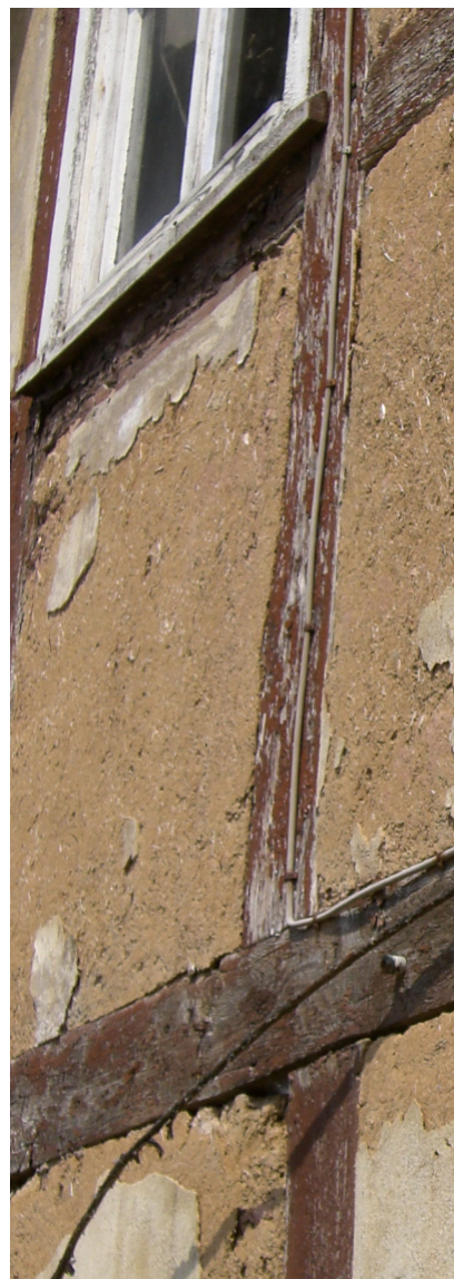
Abb. 22: Regen ist der Feind des Fachwerks
