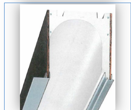
Abb. 140: 1980 Es wird besser: Kasten mit dünner Dämmung rechts, U = 0,6 \text{ W}/(\text{m}^2\text{K})
