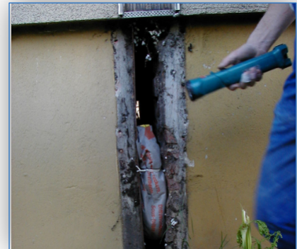
Abb. 147: Offene Trennwandfuge mit Durchblick
