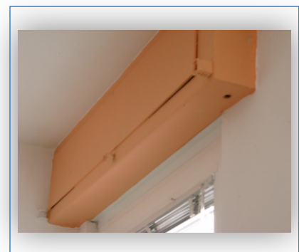
Abb. 139: 1950 ff. Undicht und mit großer Wärmeverlustfläche, U = 3,0 \text{ W}/(\text{m}^2\text{K})
