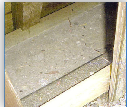
Abb. 94: 1990 Das zugehörige Originalfoto zeigt die nackte Betondecke
