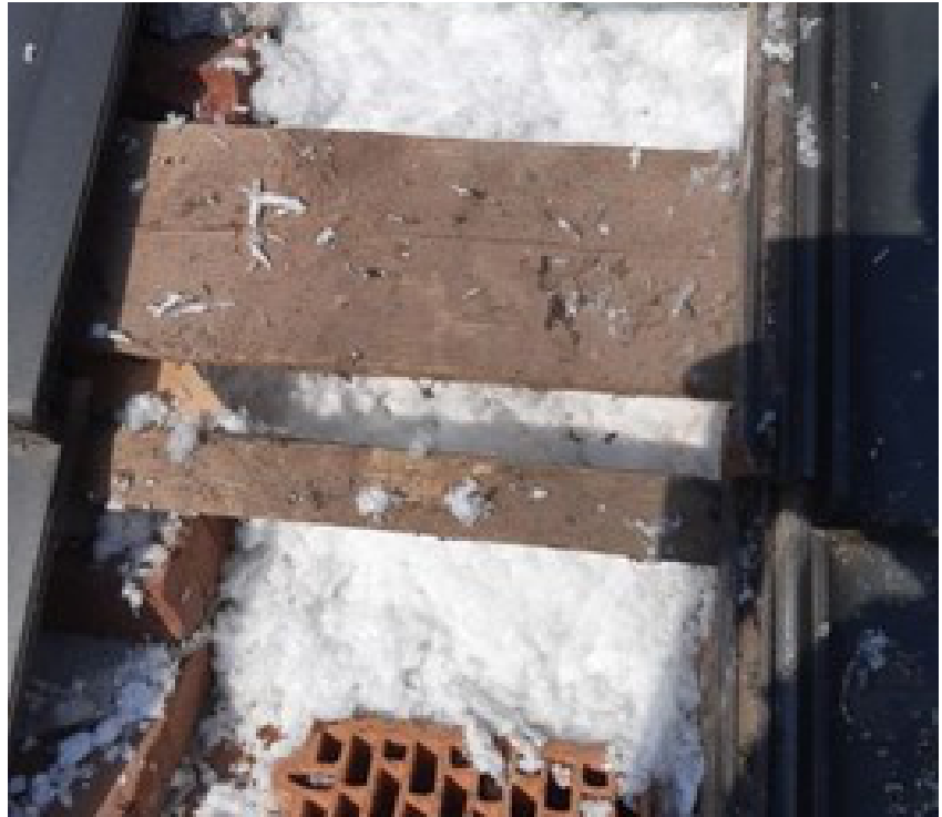
Abb. 96: Abseitendämmung von außen durch aufgenommene Dachziegel
