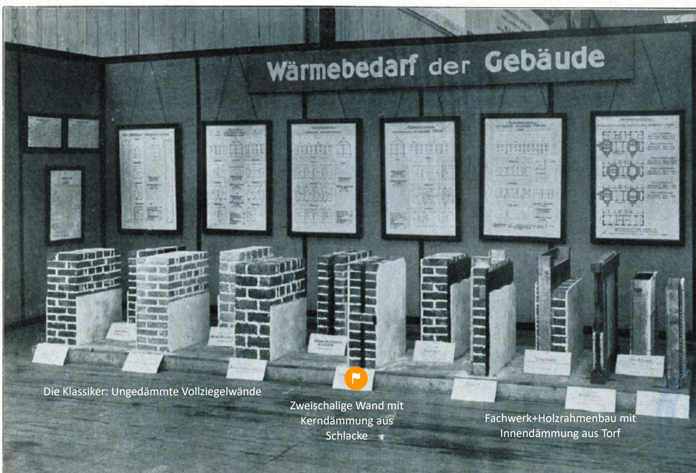
Abb. 10: Erste gedämmte Aussenwände in einer Ausstellung 1924 - Bildmitte: Kerndämmung als damals neue Technik
