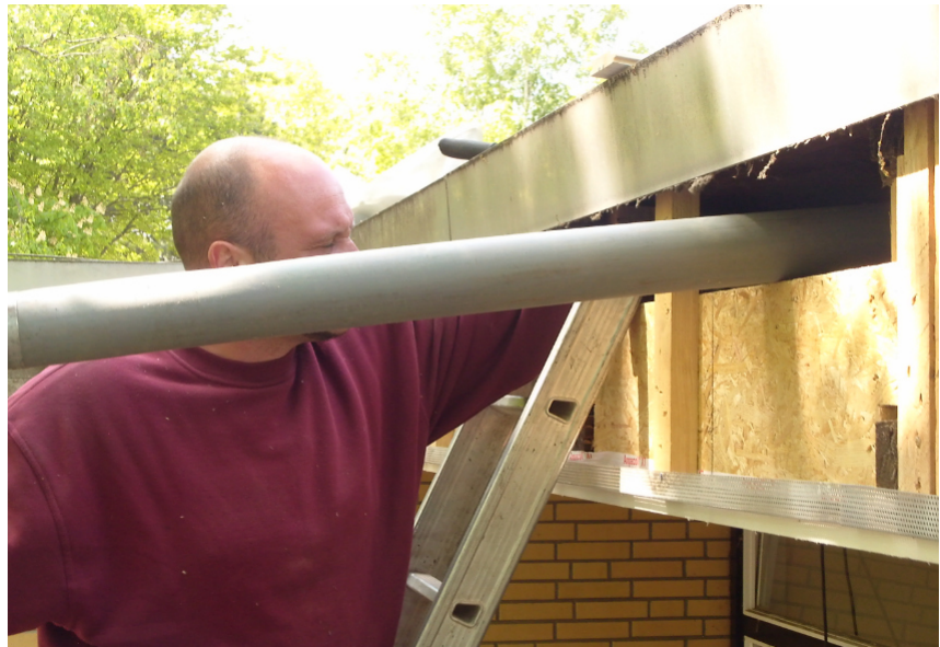
Abb. 117: Einblasen von Dämmflocken vom Dachrand
