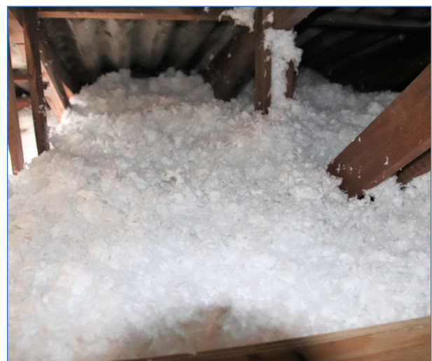
Abb. 5: Die Technik der Einblasdämmung - Vorher und Nachher auf einem Dachboden
