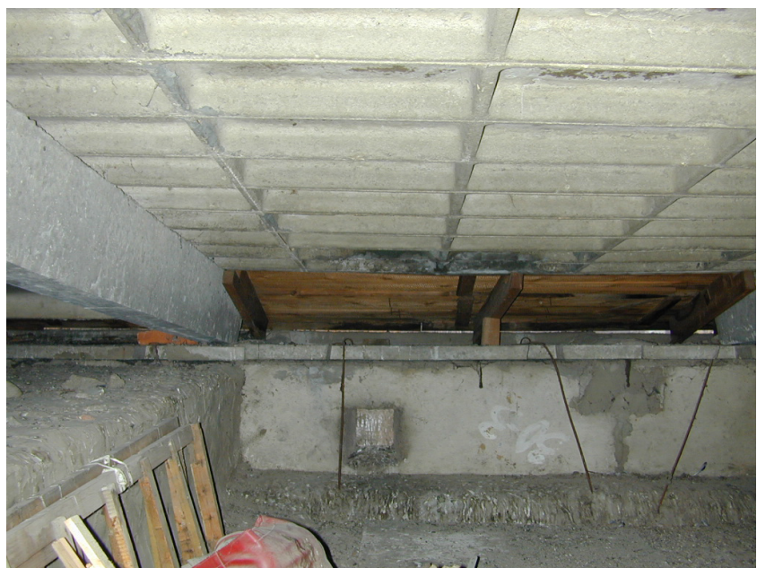
Abb. 132: Blick in den Belüftungsraum - vorgefertigtes Betonflachdach der Plattenbauweisen
