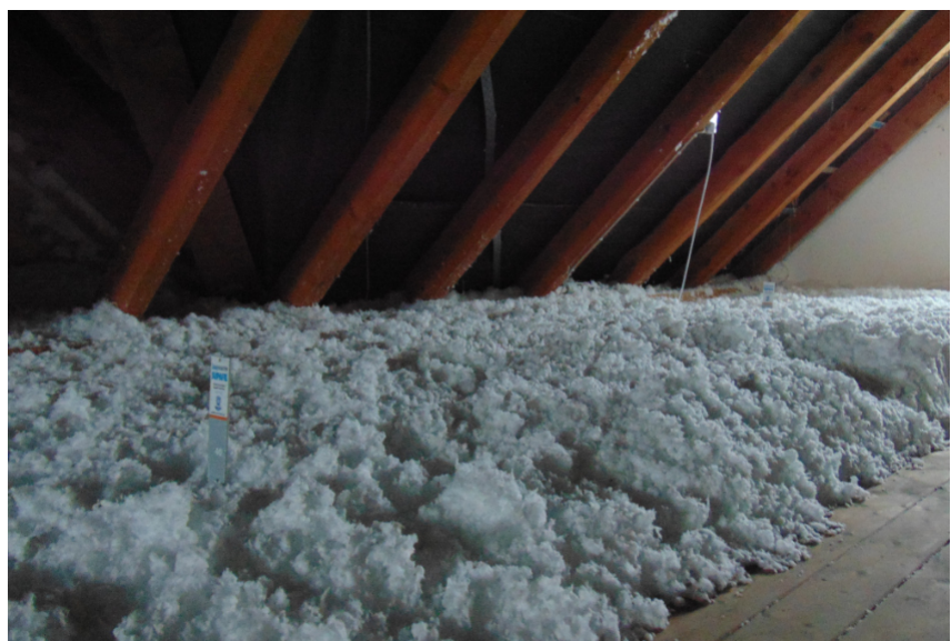
Abb 86: Einblasdämmung 35 cm dick auf der Kehlbalkenlage
