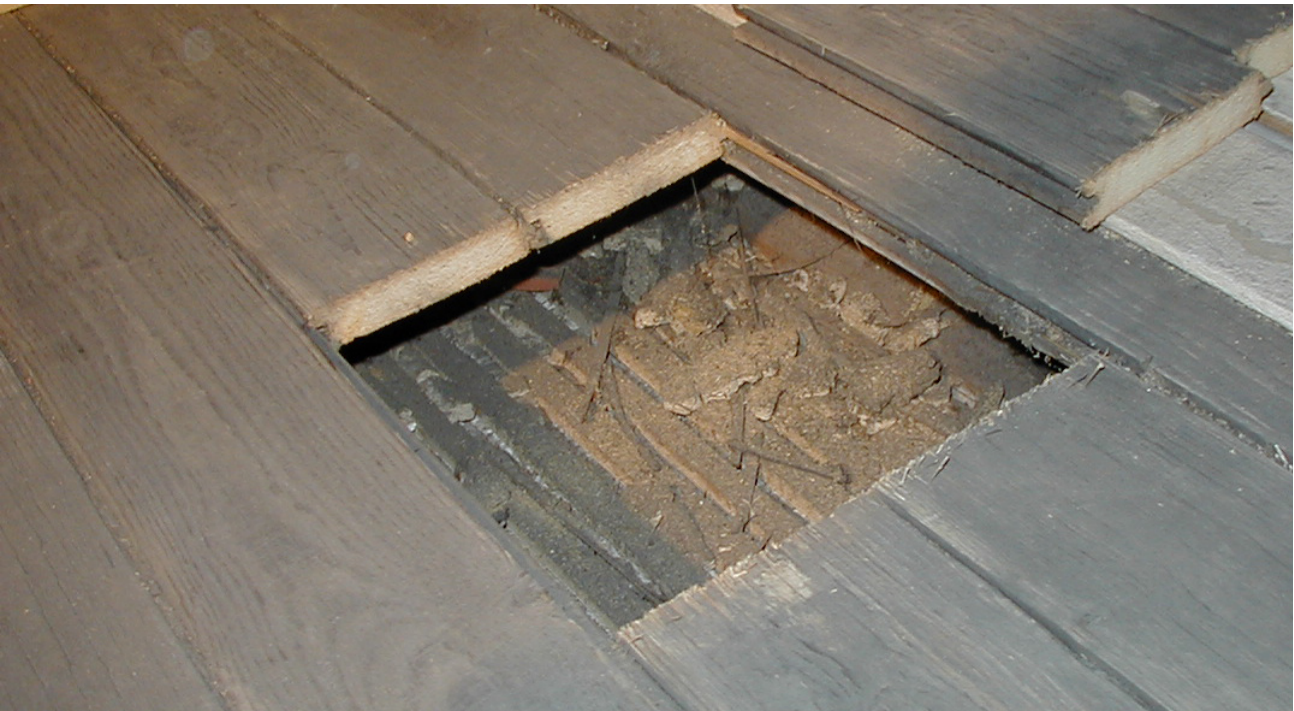
Abb. 107 + 108: Dachbodendecken aus Holzbalken sind auch im Balkenzwischenraum zu dämmen
